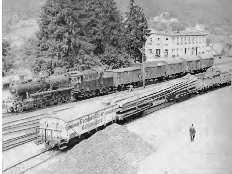
Abb. 9. u. 10. Langholztransport bei einer Vollbahn (oben, Bf. Eyach, Hohenzollern) und bei einer 760 mm-Waldbahn (Ošadnica-Zákamenné/CSSR). Während die Drehschemelwagen nach den Vollbahn-Vorschriften mittels einer Kupplungsdelchsel miteinander verbunden werden müssen, falls sie am Anfang oder inmitten eines Zuges laufen (s. a. MIBA 3/74, S. 132), ist dies bei den winzigen Drehschemel-Loren der nur als Zubringer fungierenden Waldbahn — auf Grund der völlig anders gearteten Betriebsverhältnisse — nicht vorgeschrieben bzw. nicht notwendig.
