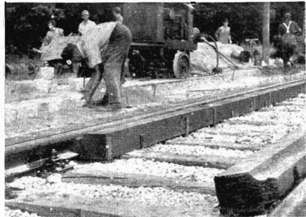
Abb. 4 Verlegung und Befestigung der maschinell hergerichteten Streichbalken
